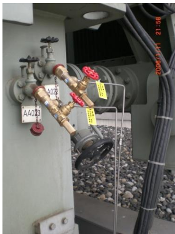
图：HYG-815Y 变压器在线监测系统安装现场进油与回油管图片
