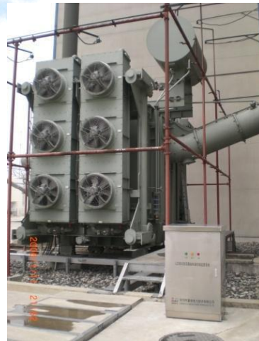
图：HYG-815Y 变压器在线监测系统安装现场进油与回油管图片
